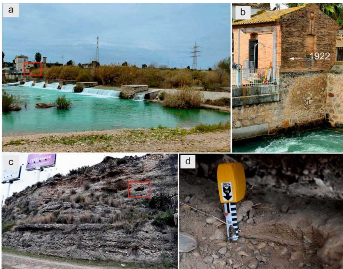
Figura 43. a: Vista de l'Assut de Borriana y localización de la caseta de operaciones. b: Localización de la marca de altura de la inundación de 1922 realizada por el Assutero según se relata en Llop Rovira y Llop López de Murillas (2019). c: Localización de los abrigos rocosos con arenas de inundación. d: Interior del abrigo con 1 nivel de arenas de paleocreencias que se atribuye a la inundación de 1787 (sedimento Millars 2, Tabla 17).
