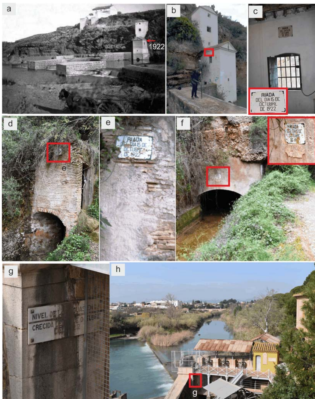
Figura 41. Instalaciones hidráulicas con limnimarcas. a: Vista de l'Assut de Vila-real en los años 1920s y edificio de manejo de la compuerta en cuya parte superior se localizan dos placas de nivel de la inundación de 1922. b: Detalle de la caseta en su exterior y localización de la marca de nivel de riada. c: Placa de nivel de la inundación de 1922 en el interior del edificio y detalle de la misma. La altura topográfica de la base de ambas placas es exactamente la misma, 52.77 m (s.n.m.). d: Derramador de La Portella (punto Botànic 1; Tabla 16) con una placa exterior que indica el nivel de la inundación de 1922 (recuadro en rojo). e: Detalle de la placa de la foto d. f: Séquia Major con una limnimarca de la riada de 1922, y detalle de la misma (Botànic 2). g: Placa de nivel de la riada de 1922 en l'Assut d'Almassora. h: Vista de l'Assut d'Almassora y localización de la limnimarca g. Al fondo se divisa el puente de Sta. Quiteria.
